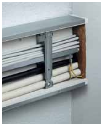
Die Kanalbrandschottung dichtet Wand - alte Deckendurchgänge zuverlässig ab
