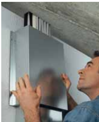
Die Schiebemuffe sorgt für saubere Abschlüsse
