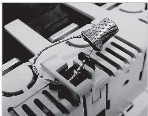
Блокировка клеммной крышки свинцовой пломбой
