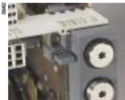
Блокировка вкатывания при открытой дверце
