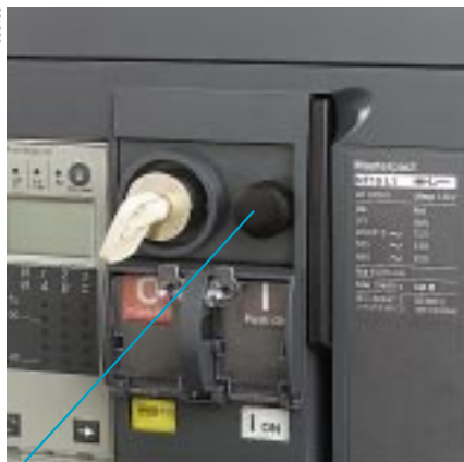
Кнопка электрического включения (BPFE)
