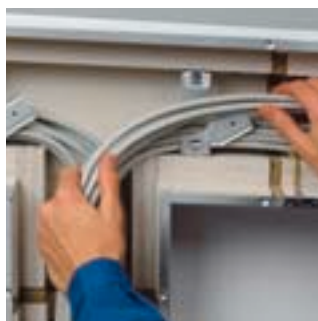
После установки канала провода легко укладываются, как и в любой канал от «Tehalit». Последующий монтаж проводится легко благодаря съемным верхним крышкам.
